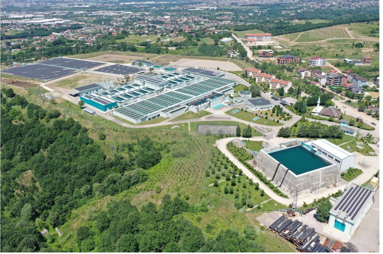
İzmit İme Suyu Arıtma Tesisi Güneş Enerjisi Santralleri (GES)
